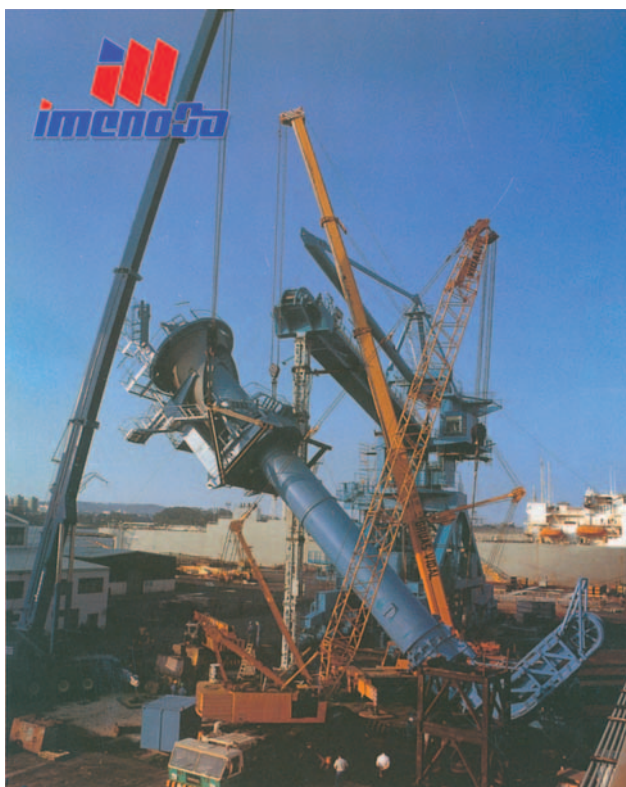
▲ Montaxe da descargadora de carbón. Porto de Ferrol.
